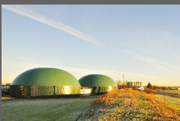
Biogas und KWK
